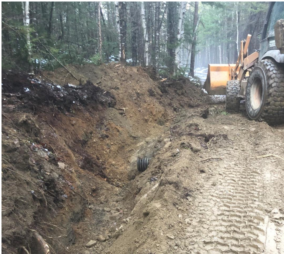
Photo 37 Remplacement ponceau de drainage, DRpt-48
