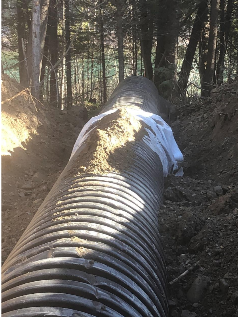
Photo 7 Installation du ponceau
