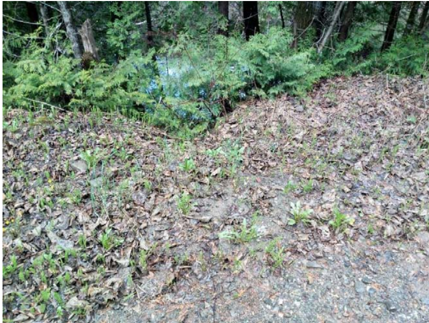
Photo 30 Eaux de ruissellement dirigées vers la rivière, avant les travaux
