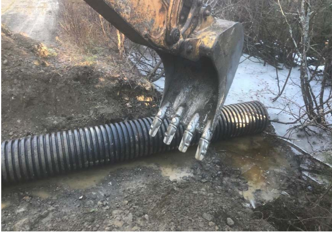
Photo 40 Pose du ponceau de drainage 60 cm, 35-DR1
