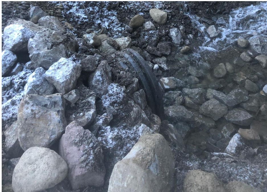
Photo 3 Stabilisation de l'entrée du ponceau
