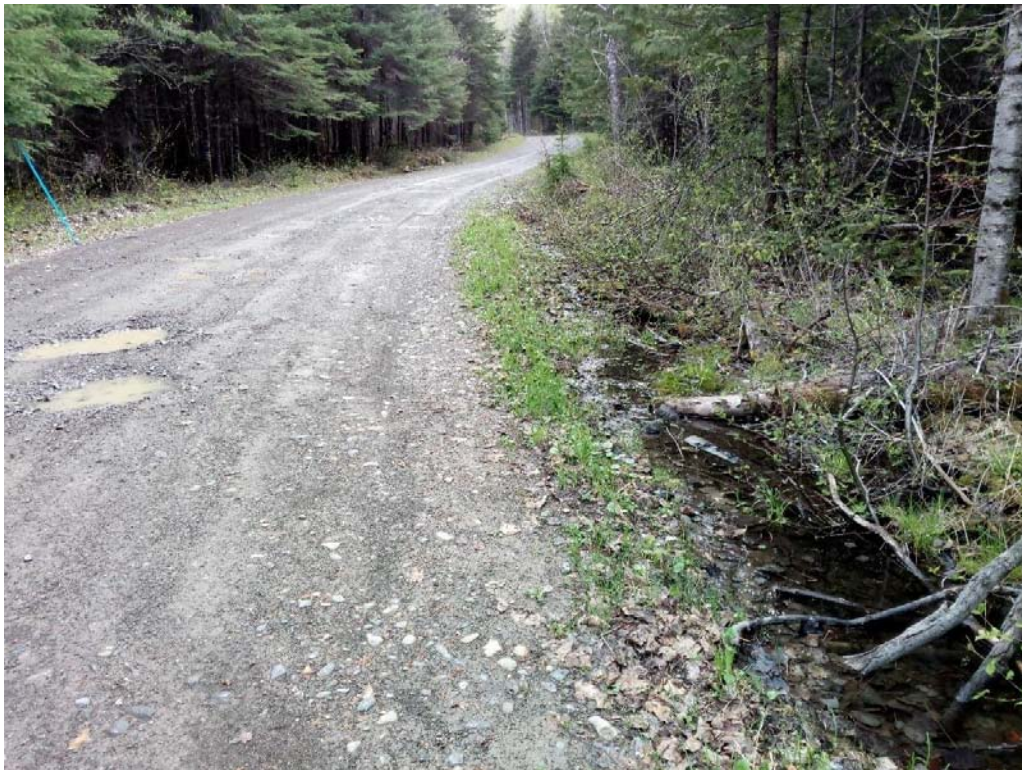
Photo 29 Absence de ponceau
