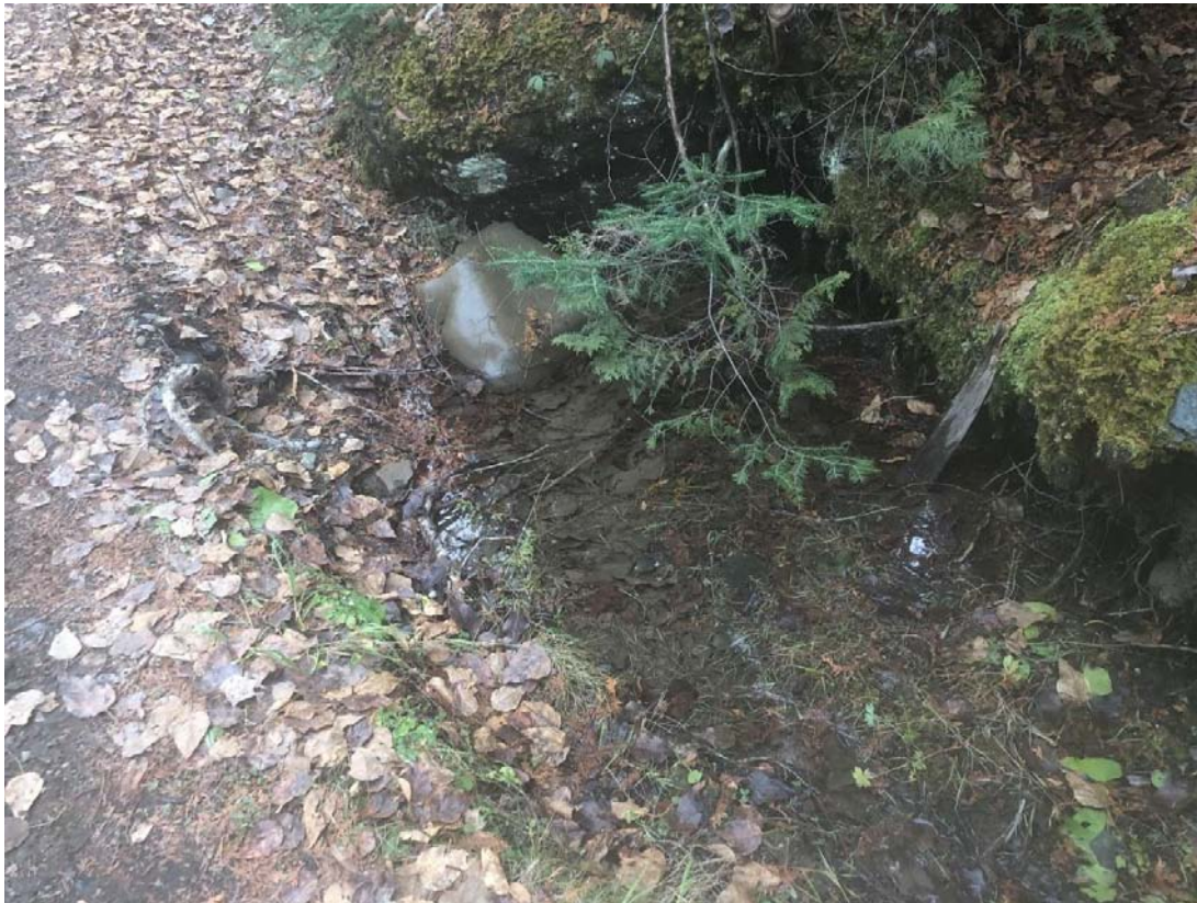
Photo 39 Tête du ponceau obstruée, 27-DR1
