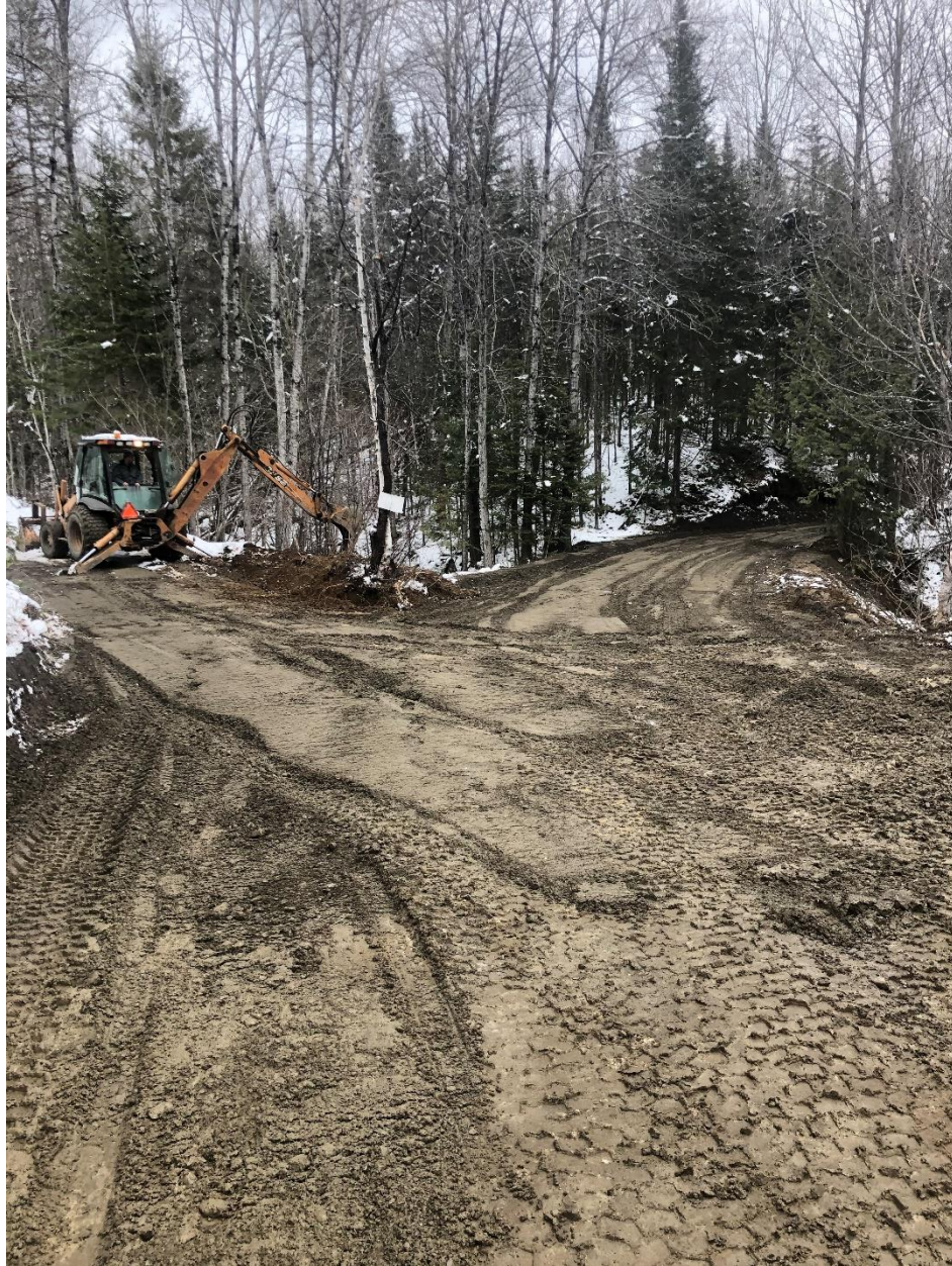
Photo 14 Correction de la pente du chemin afin de dévier les eaux
