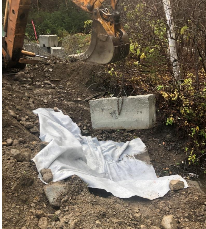
Photo 21 Pose des blocs de béton
