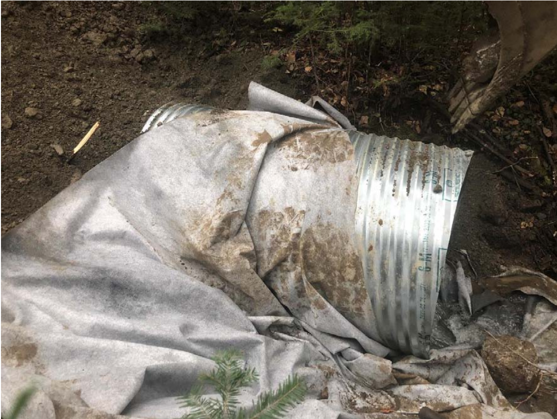
Photo 13 Stabilisation du ponceau
