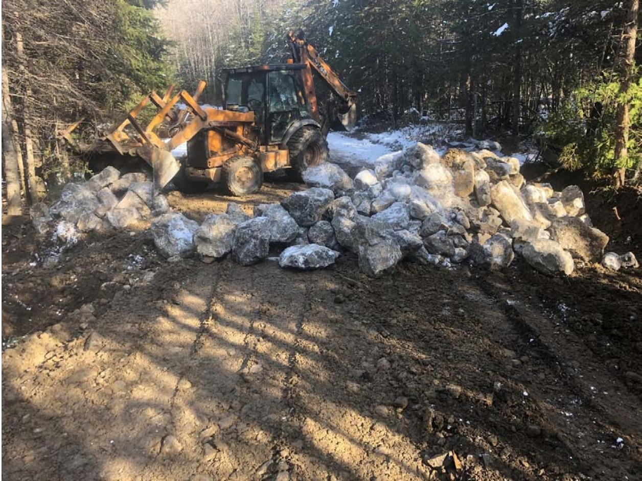
Photo 17 Mise en place de l'enrochement
