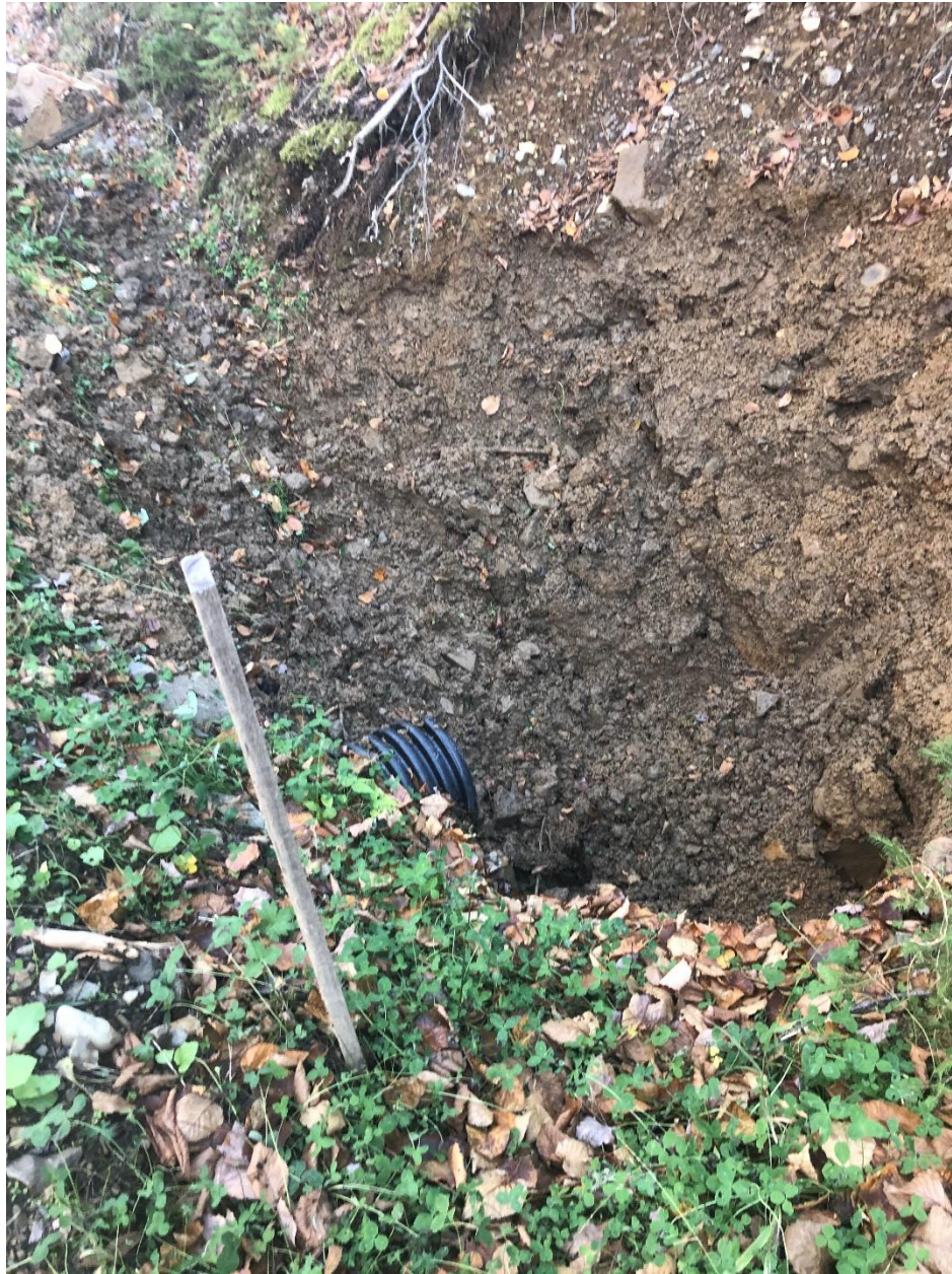
Photo 43 Ponceau dégagé, R-DR17
