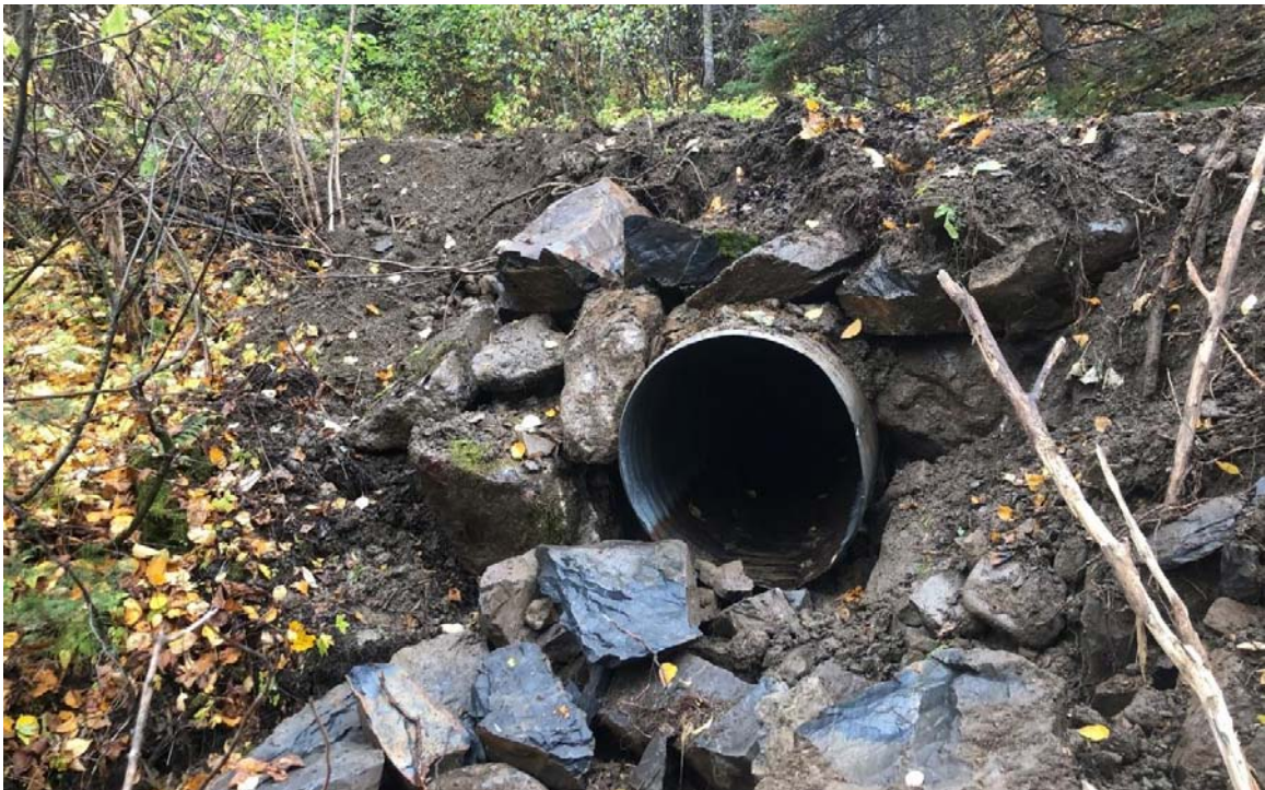
Photo 28 Après les travaux
