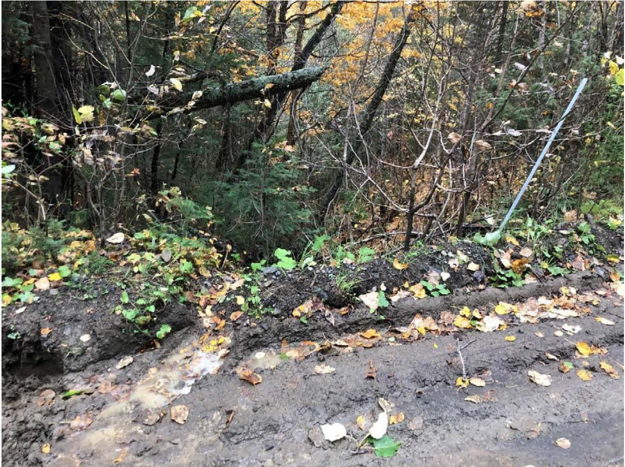
Photo 45 Ruissellement sur la tête du ponceau, avant les travaux, D87-CD3
