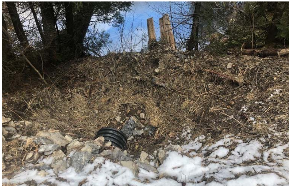
Photo 31 Bassin de sédimentation
