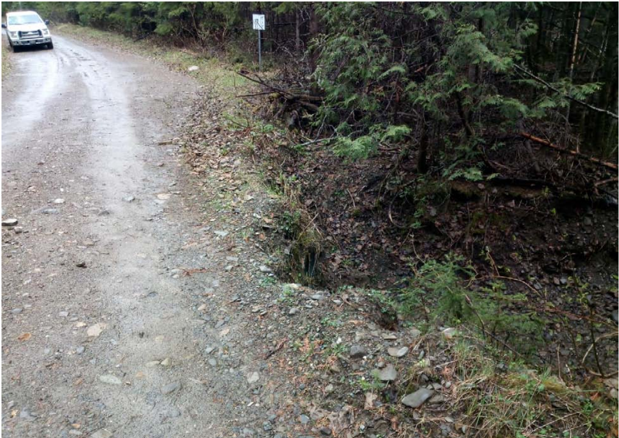
Photo 15 Remblais aval très instables
