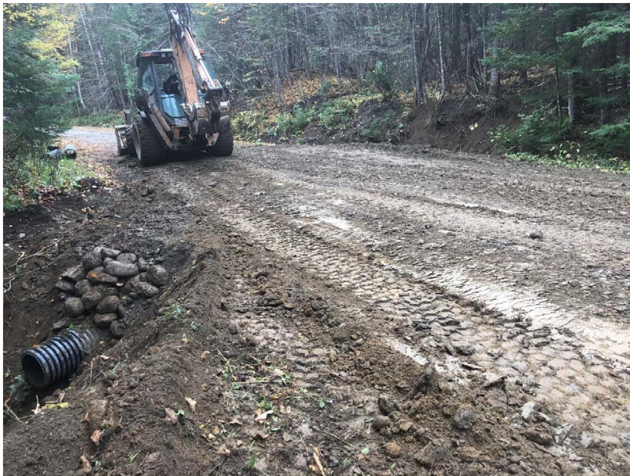
Photo 46 Gestion des eaux à l'aide d'un ponceau, D88-CD1
