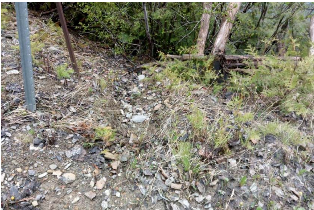
Photo 34 Sédimentation vers la rivière, avant les travaux
