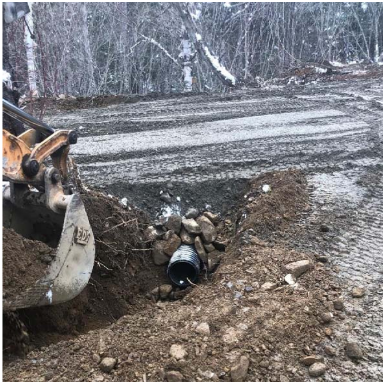
Photo 12 Drainage installé à l'ouest de la traverse
