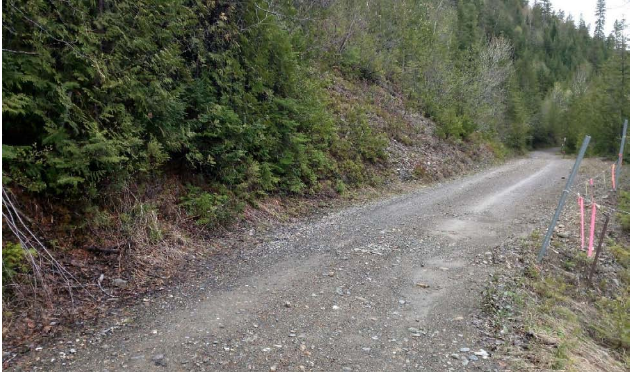
Photo 33 Montagne à gauche et déblais instables à droite, avant les travaux
