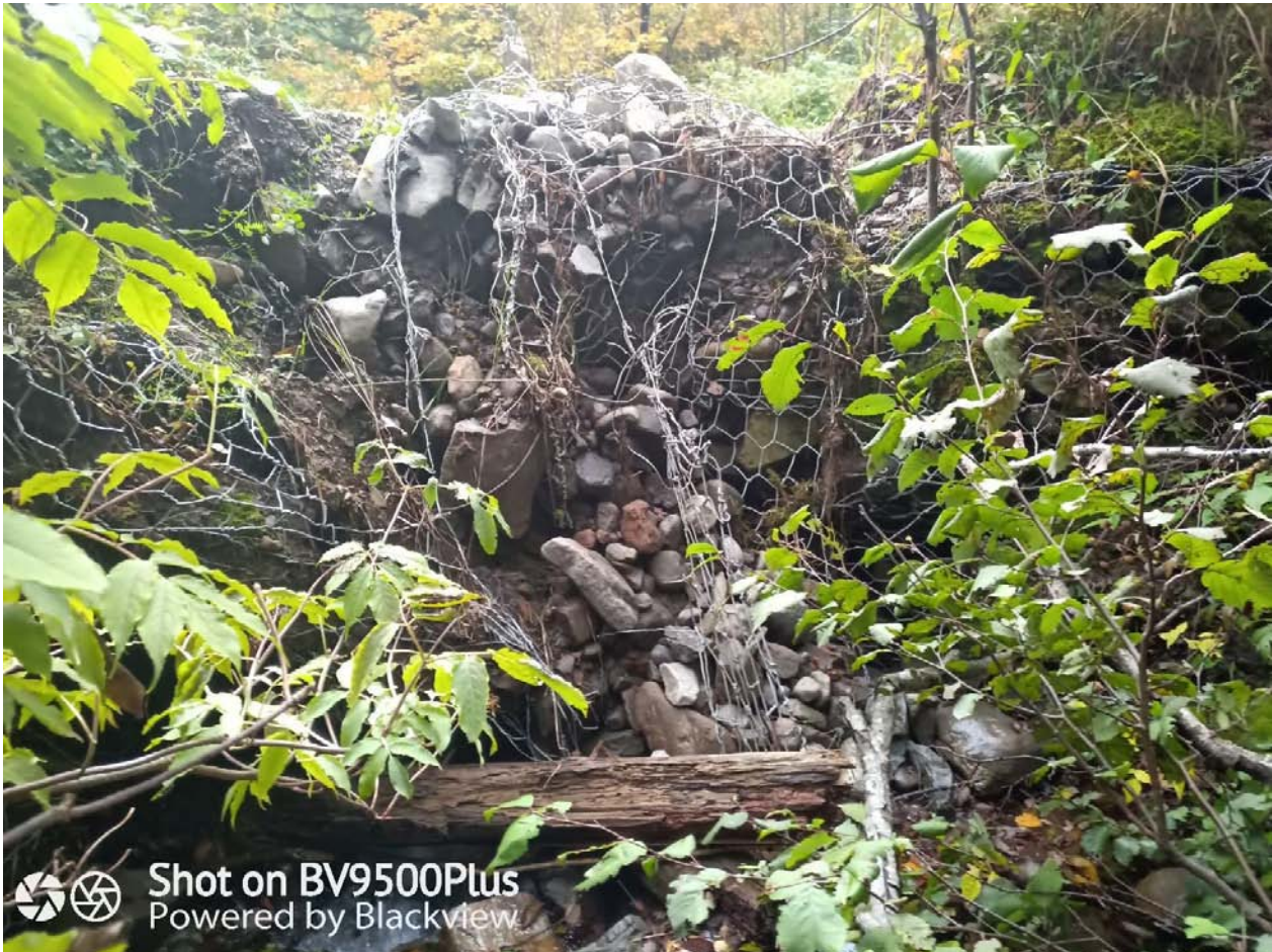
Photo 20 Caissons de roche en mauvais état
