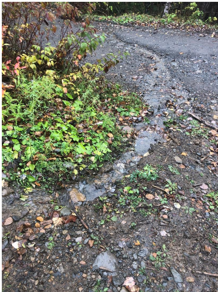
Photo 9 Eaux de fossé qui ruisselle sur la tête du ponceau
