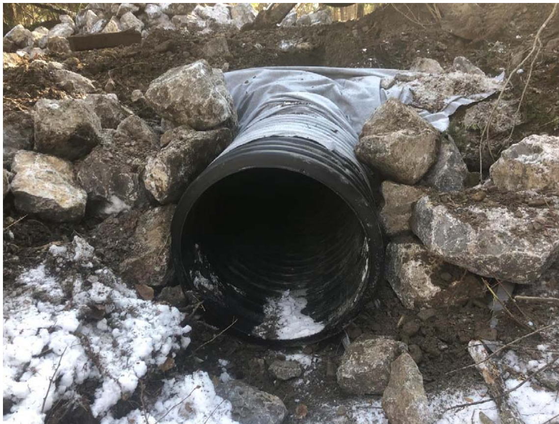
Photo 18 Stabilisation en cours
