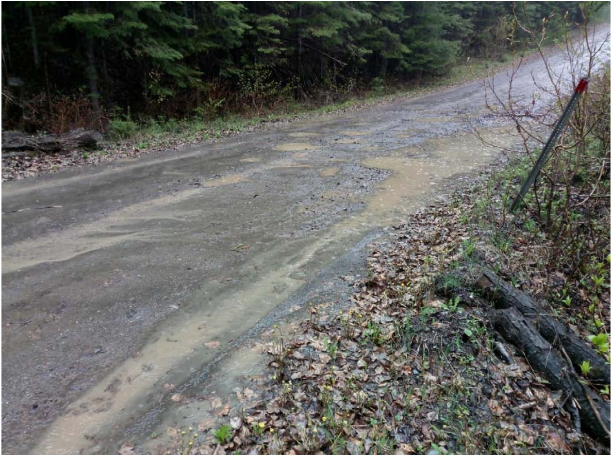
Photo 26 Accumulation d'eau de ruissellement sur la traverse
