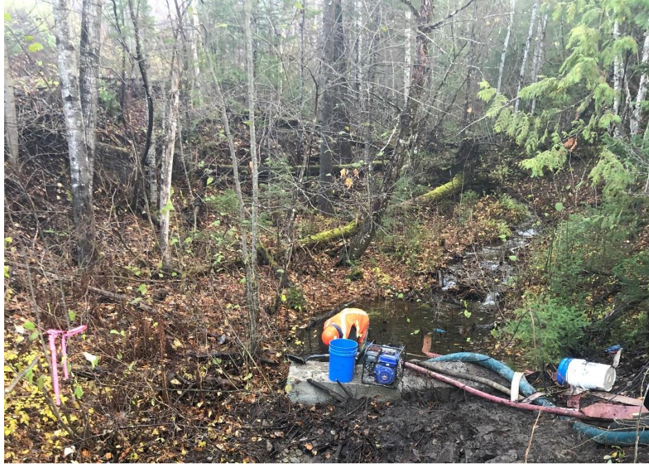
Photo 11 Installation des pompes pour le travail à sec
