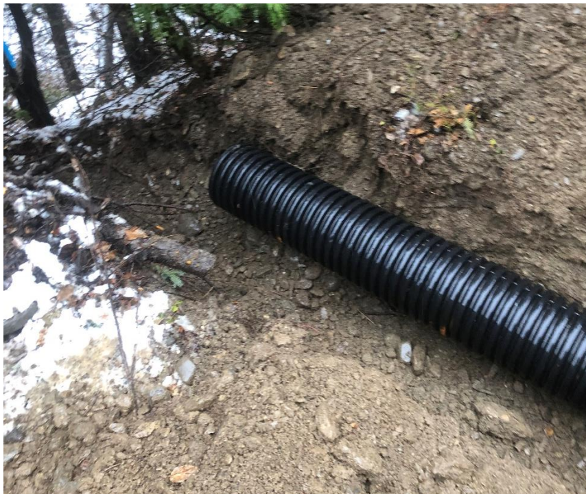
Photo 36 Installation d'un ponceau de drainage
