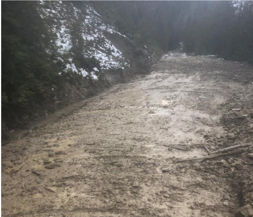
Photo 35 Fossé à gauche et ourlet pour protéger le déblai à droite
