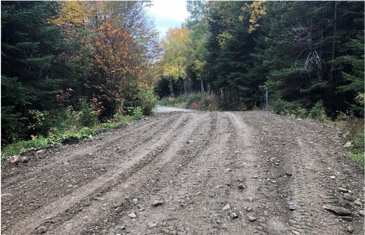
Photo 25 Mise en forme
