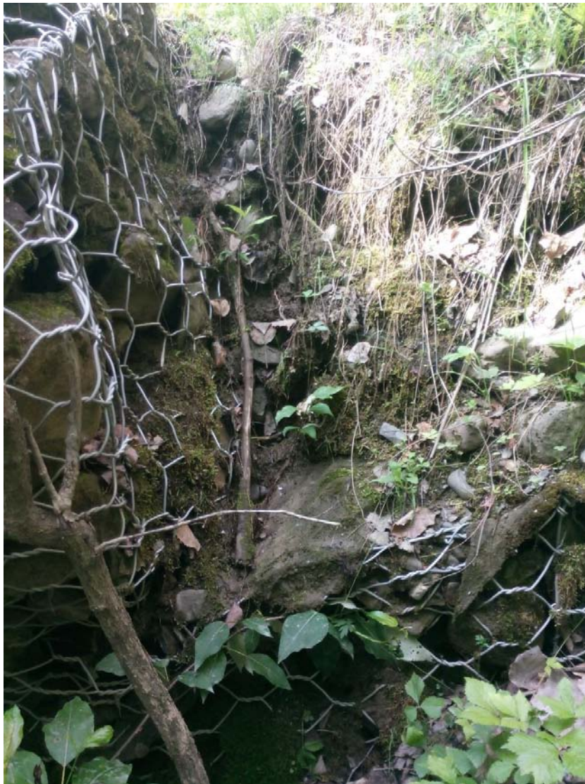
Photo 8 Remblais aval instables
