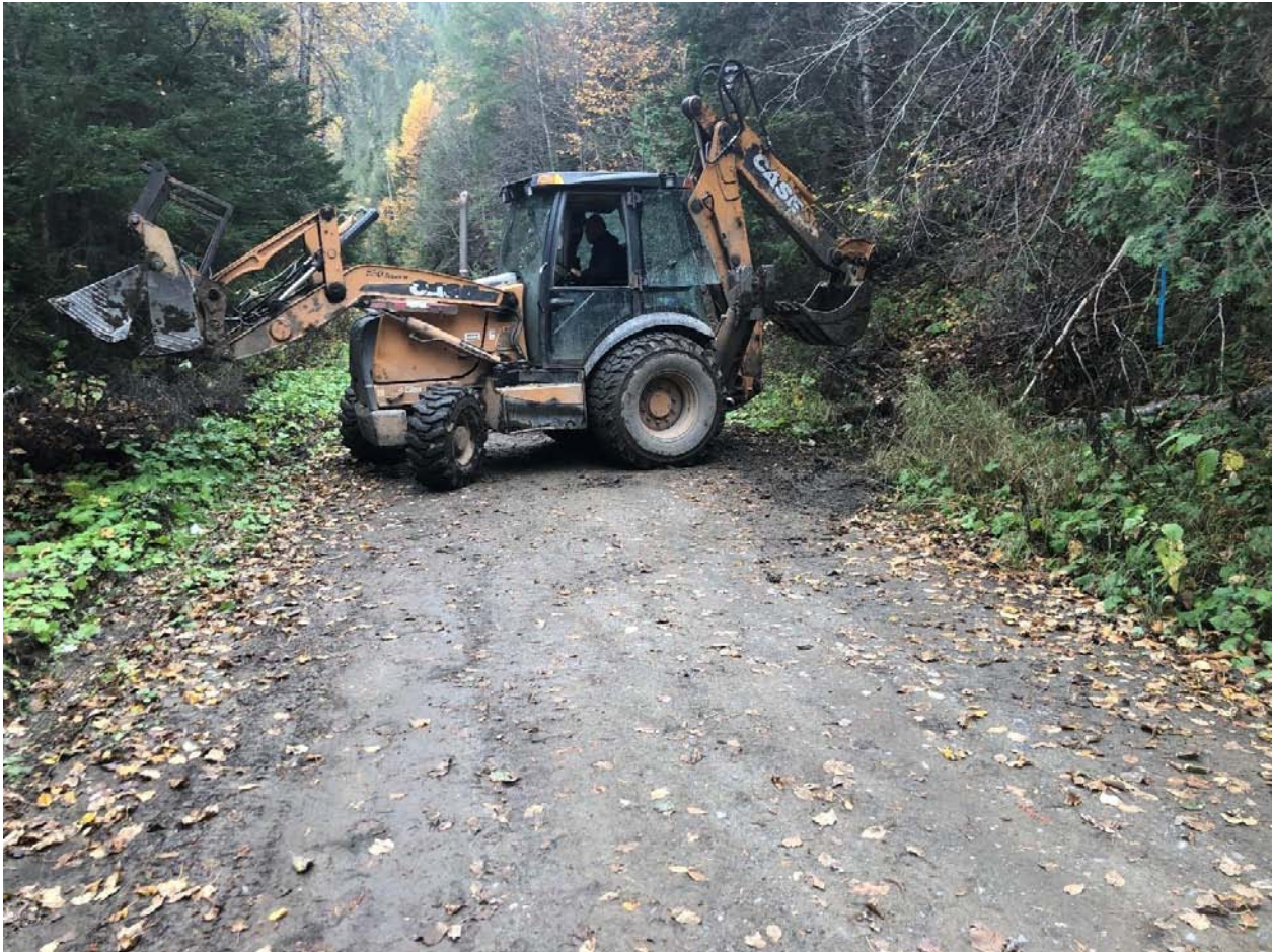
Photo 32 Travaux en cours
