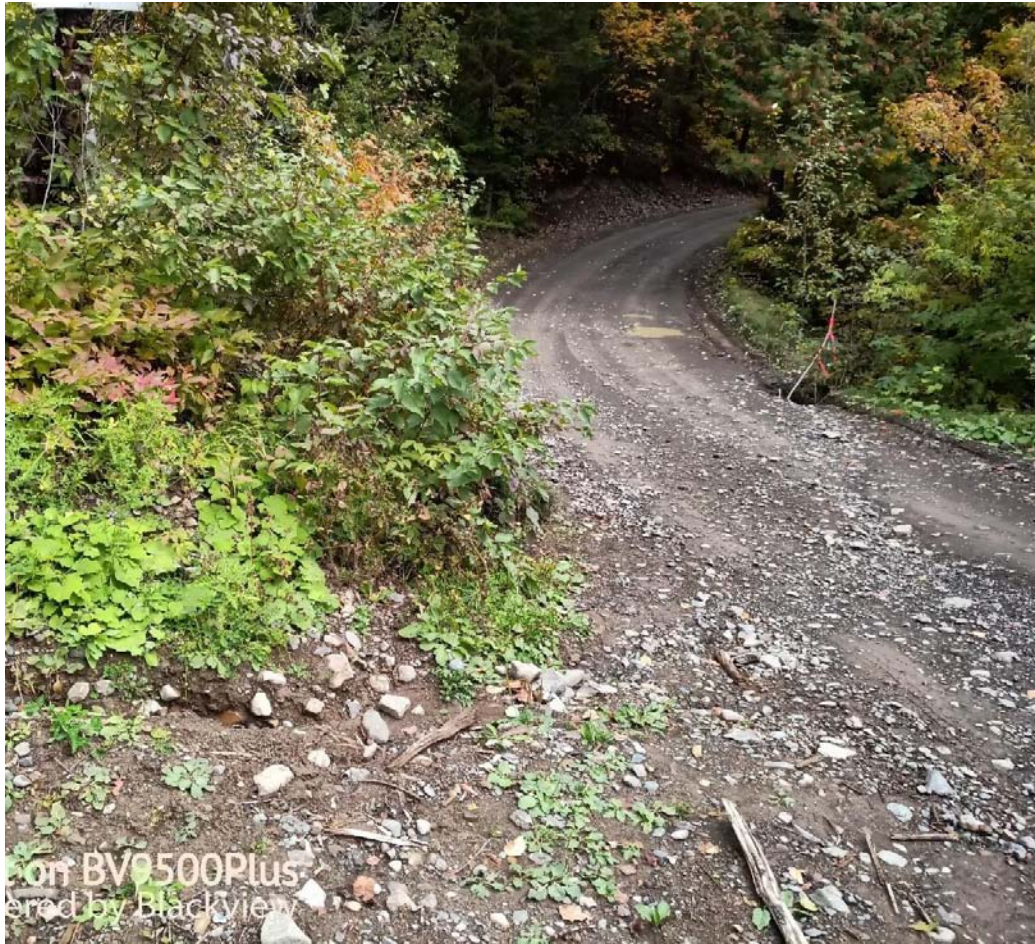
Photo 10 Ponceau au point le plus bas et remblais aval instables
