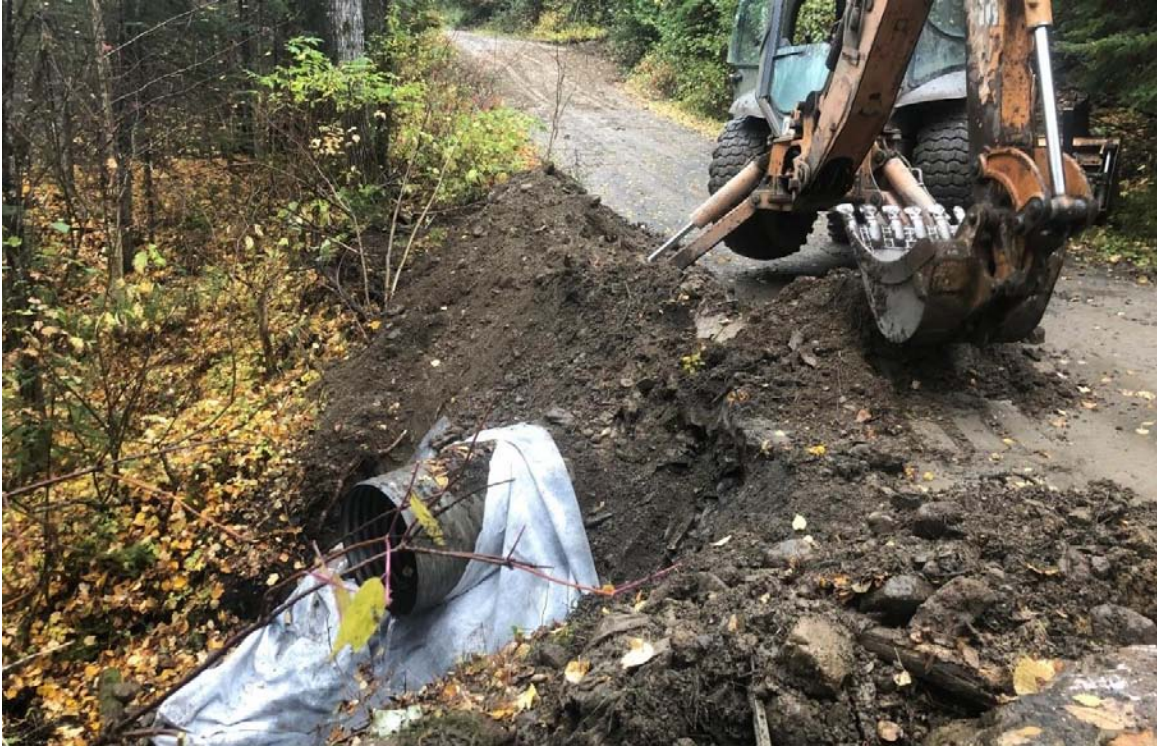
Photo 27 Stabilisation de la tête du cours d'eau
