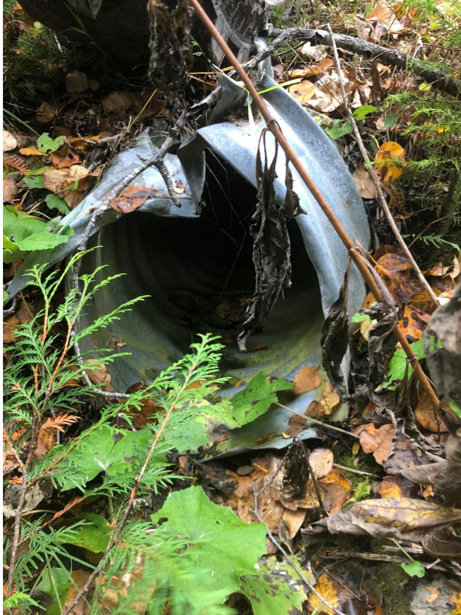
Photo 42 Avant les travaux, D89-DR1
