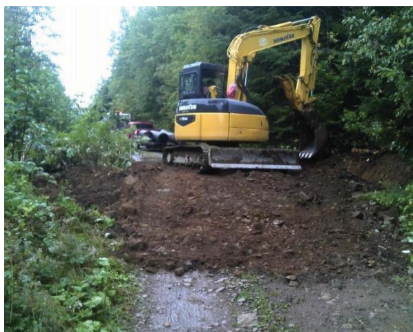
Figure 29. C70-DR2 – Remplacement du ponceau de drainage
