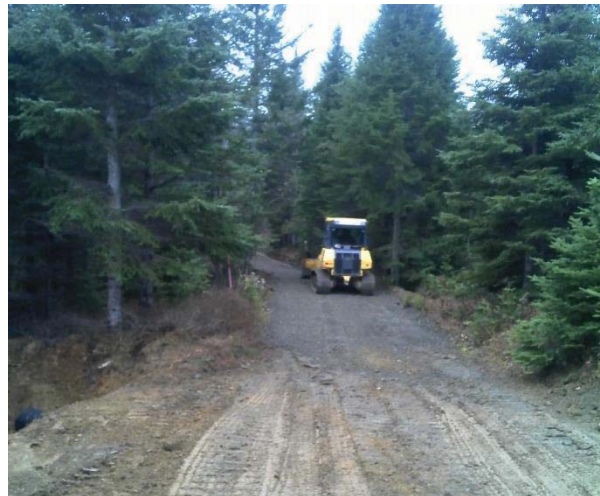
Figure 19. Mise en forme du chemin près du ponceau de drainage
