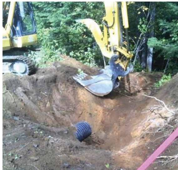
Figure 4. Drainage installé au sud de la traverse
