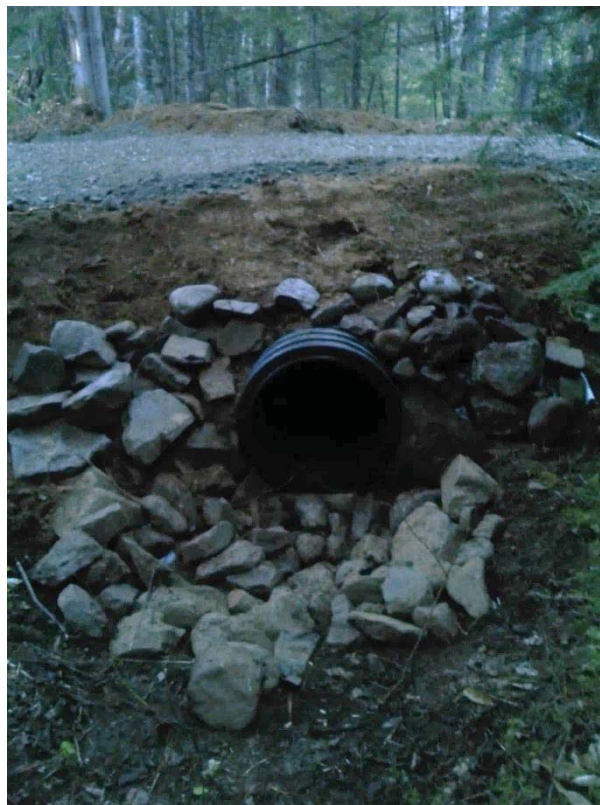
Figure 20. Amont du ponceau
