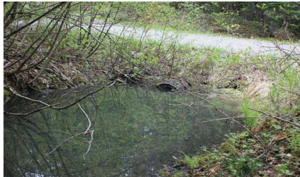
Figure 34. B3-DR2– Avant les travaux
