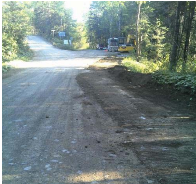
Figure 37. Rivière-CD3 – Digue retravaillée
