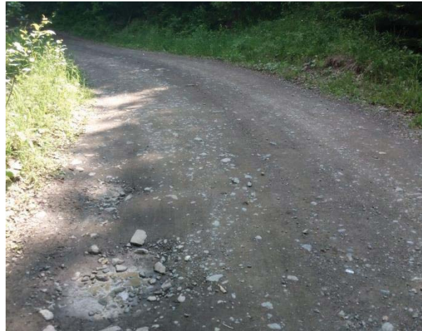
Figure 7. Accumulation d'eau au-dessus du ponceau, ce qui entraîne des sédiments et déstabilise le remblai
