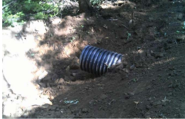
Figure 31. C70-DR8 – Ponceau de drainage après les travaux
