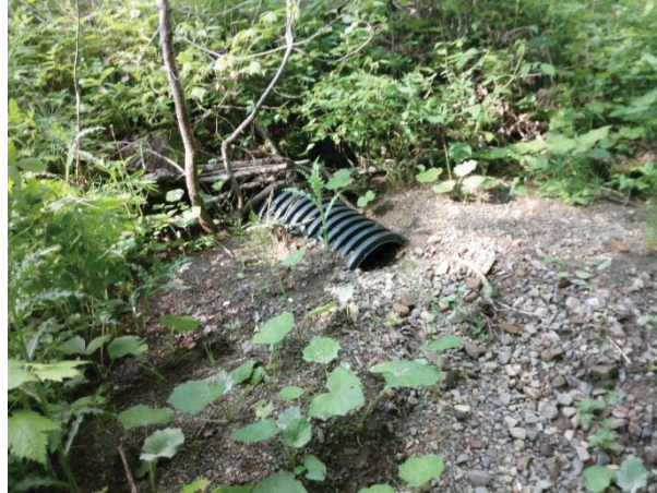
Figure 33. B4-DR1– Avant les travaux
