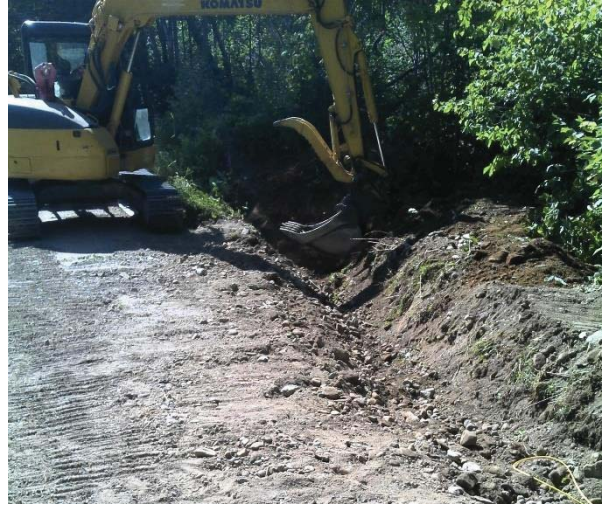
Figure 40. B3-CD1 – Eau dirigée à l'extérieur du 20 mètres
