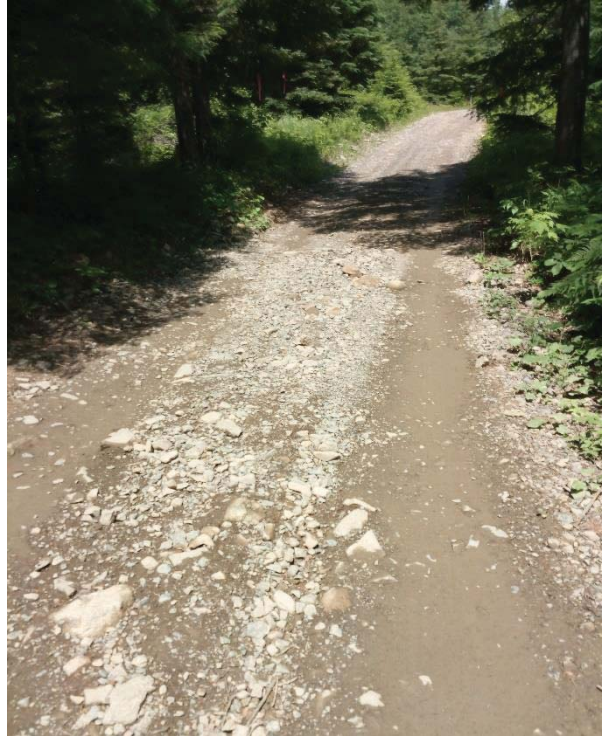
Figure 16. Surface de roulement érodée au site de traversée de l'eau (absence de ponceau)
