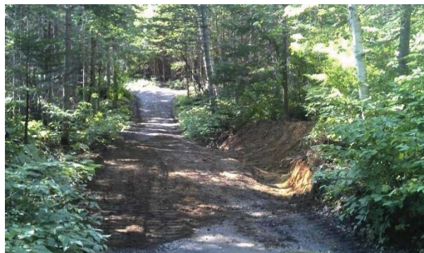
Figure 42. Luna 1 – Le chemin est situé à 30 mètres de la rivière. Le chemin a été profilé de façon à diriger l'eau dans un bassin situé du côté opposé de la rivière.
