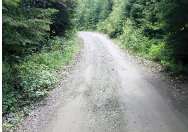
Figure 26. C70-CD1 – Eaux de ruissellement du chemin qui se dirigent à la tête du ponceau
