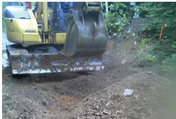
Figure 28. C70-CD1 – Lors de la pose du ponceau de drainage
