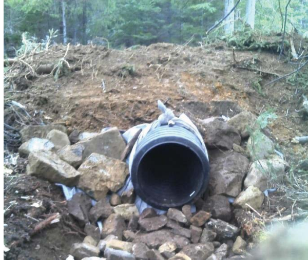
Figure 18. Aval du ponceau
