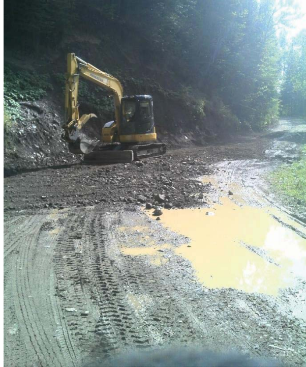
Figure 43. B4-DR6 – Accumulation d’eau au-dessus de la traverse de cours d’eau
