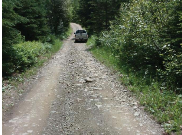
Figure 21. Érosion dans le chemin avant les travaux, C70-DR7.5-IMP
