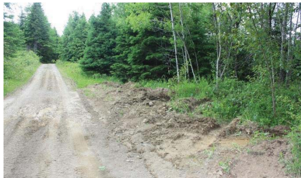
Figure 25. C70-CD1 – Bande riveraine exposée et eaux de ruissellement non gérées
