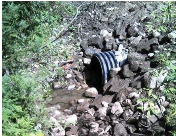
Figure 5. Enfouissement du ponceau en aval
