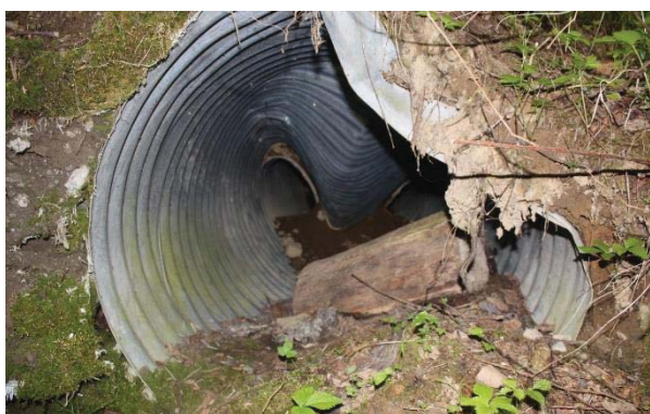
Figure 30. C70-DR8 – Ponceau de drainage avant le remplacement
