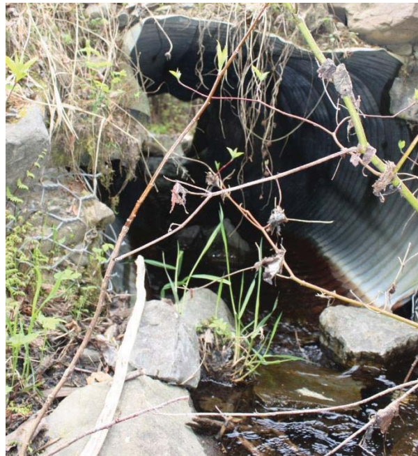
Figure 8. Ponceau déformé et remblai insuffisant
