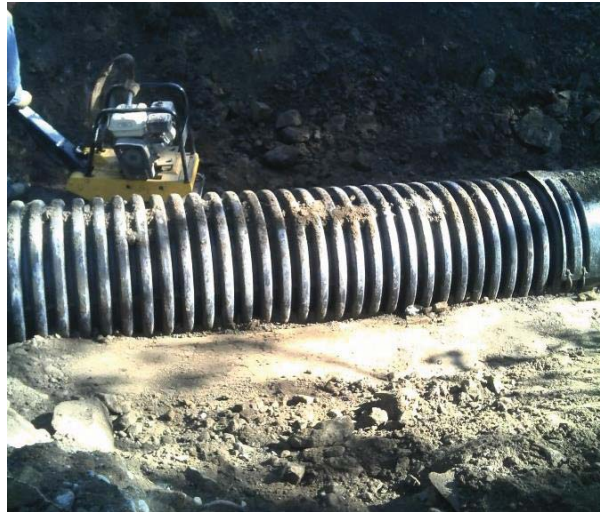
Figure 3. Travail à sec et compactage de la traverse
