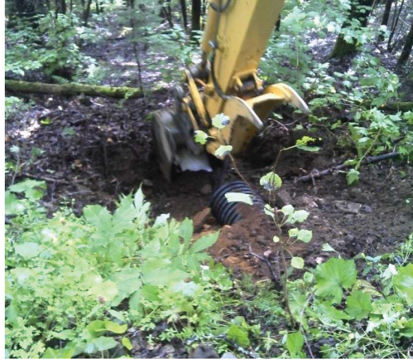
Figure 36. B4-DR4 – Pendant les travaux
