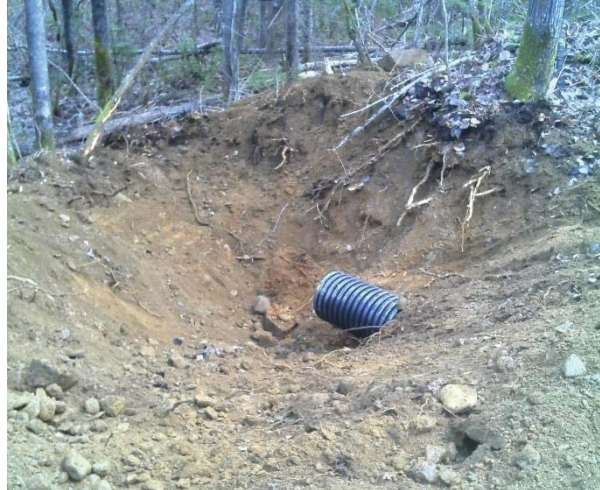
Figure 23. Ponceau de drainage ajouté C69-DR2
