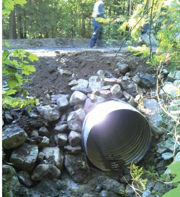
Figure 13. Finition de l'aval du ponceau
