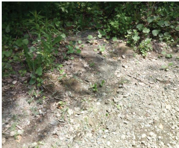
Figure 27. C70-CD1 – Sédiments accumulés à la tête du ponceau
