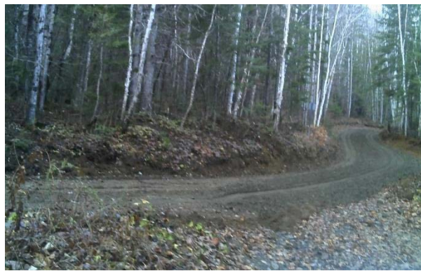
Figure 24. Bas de la pente retravaillée
