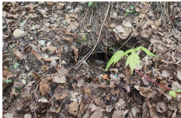
Figure 35. B4-DR4 – Avant les travaux
