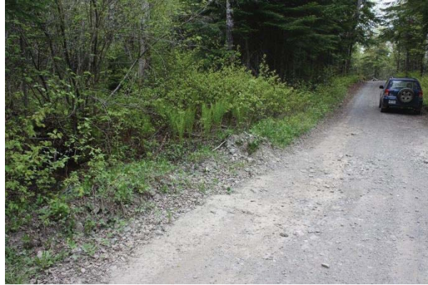
Figure 38. B3-CD1 – Eau de ruissellement qui s'accumule et coule à la tête du ponceau
